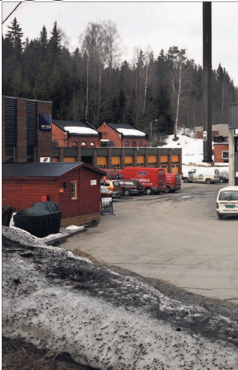
FJERNVARME: – Vi håper å gå over til biobrenselet flis som oppvarming av bygningene i Raufoss
